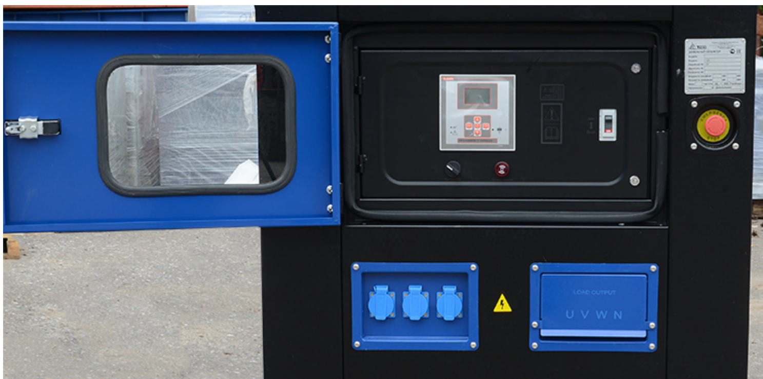
Окошко для визуального контроля за работой и кнопка остановки дизель генератора находятся непосредственно на корпусе кожуха
